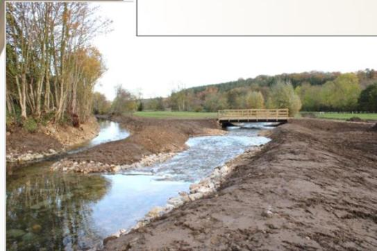
A la diffuence, la rampe envoyée permettra de stabiliser les débits entre les deux bras. L'ouvrage est solidement ancré dans le sol à 1m environ. Cette rampe fera 25 m de long.
